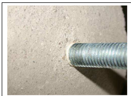
Ancoraggio di rinforzi metallici
