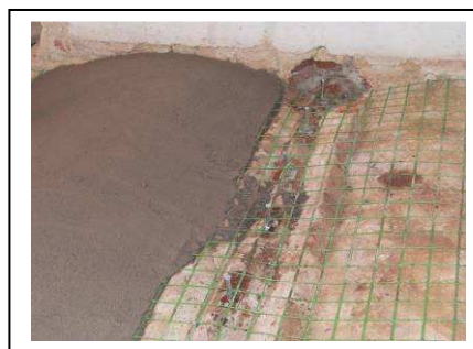
Ringrosso dell'estradosso di solai a volta
