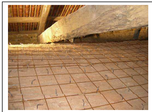
Consolidamento dell'estradosso di volte affrescate
