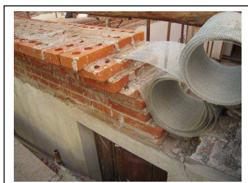
Esecuzione di cordoli armati in mattone con reti di acciaio
