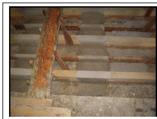
Esecuzione di sistemi compositi di consolidamento e rinforzo con TD13SRG e reti in fibre di basalto
