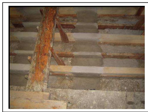
Esecuzione di sistemi compositi di consolidamento e rinforzo con TD13K e reti in fibre di basalto
