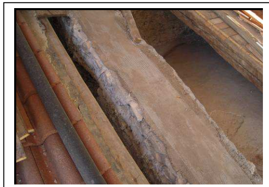
Esecuzione di rinforzo con TD13K e fibra di acciaio su contrafforti di volte
