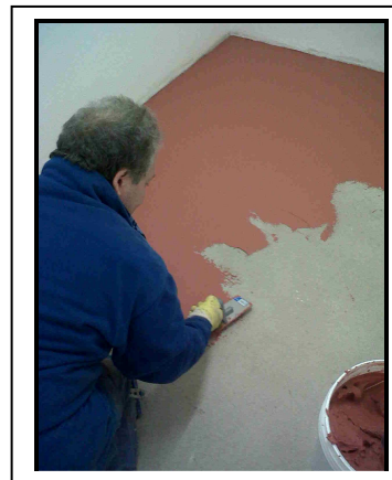
Stesura di PASTELLONE colorato su massetto HD SYSTEM DOMUS VR
