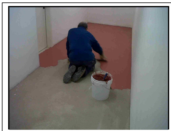
Stesura di PASTELLONE colorato su massetto HD SYSTEM DOMUS VR
