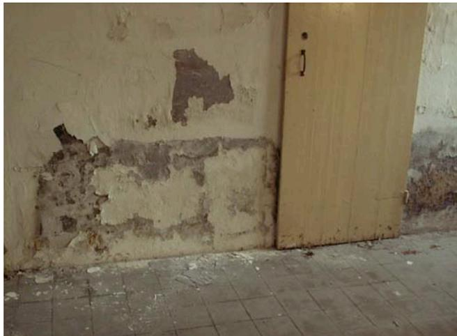
ristagno dell'acqua provoca il deposito di sali che in fase di cristallizzazione aumentano di volume causando sbollamenti e distacchi dei rivestimenti.
